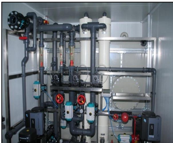
2. ábra. Membránkontaktor üzemi megvalósítása (Hidrofilt)
